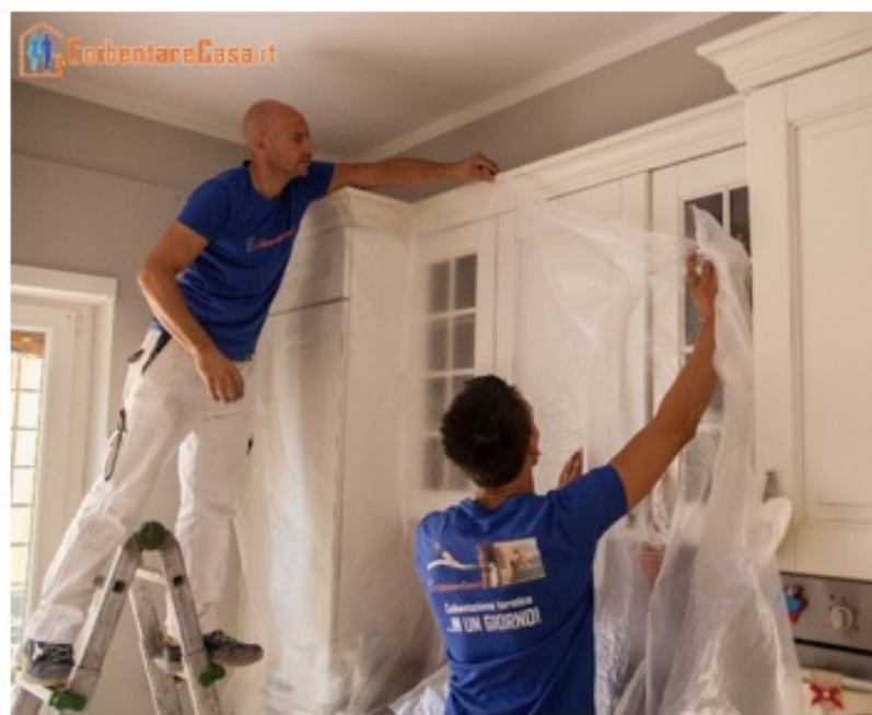
Copertura con teli in pvc mobilia
