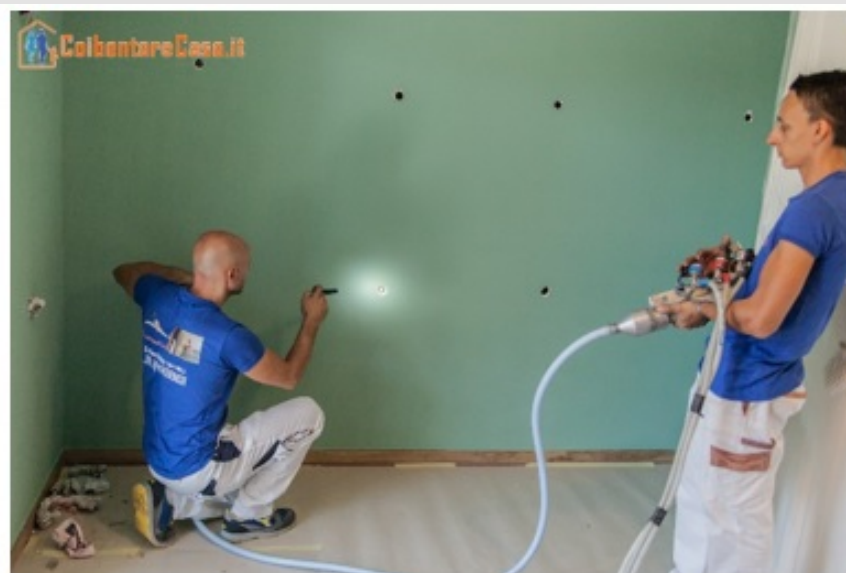
Insufflaggio pareti interno alla casa
