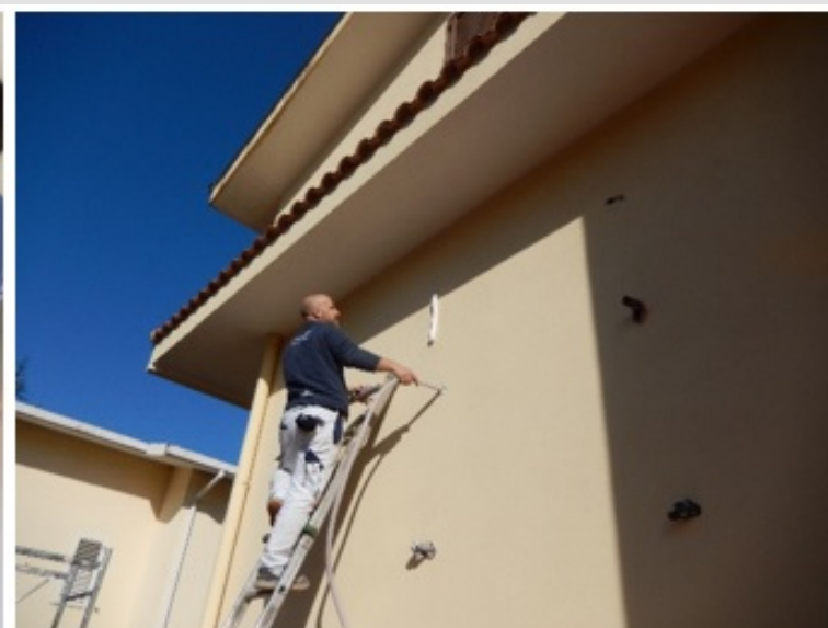
Insufflaggio pareti esterno alla casa
